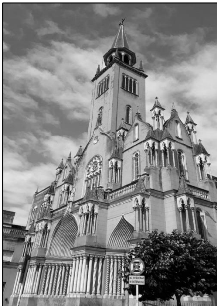
Fachada de la Iglesia San Francisco con los detalles de su arquitectura que la hacen única en nuestra ciudad
